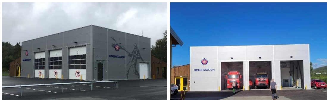
Bilde 11: Åfjord brannstasjon. Foto: FBRT
