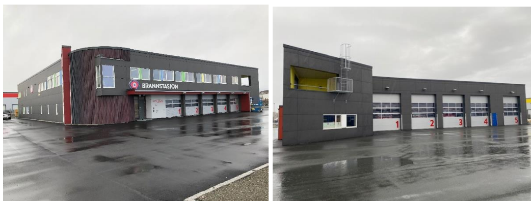
Bilde 9: Brekstad brannstasjon. Foto: FBRT
