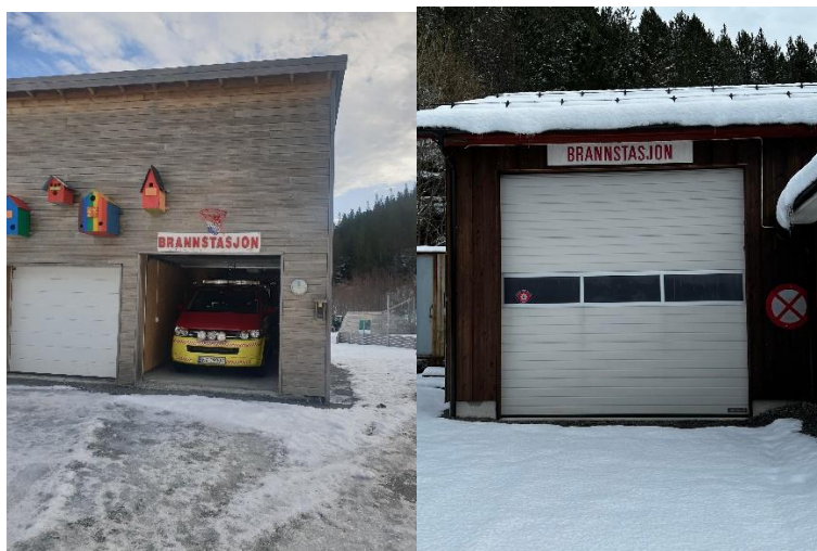
Bilde 13: Stoksund, Lysøysundet branndepot. Foto: FBRT
