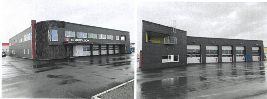
Bilde 8: Brekstad brannstasjon. Foto: FBRT
