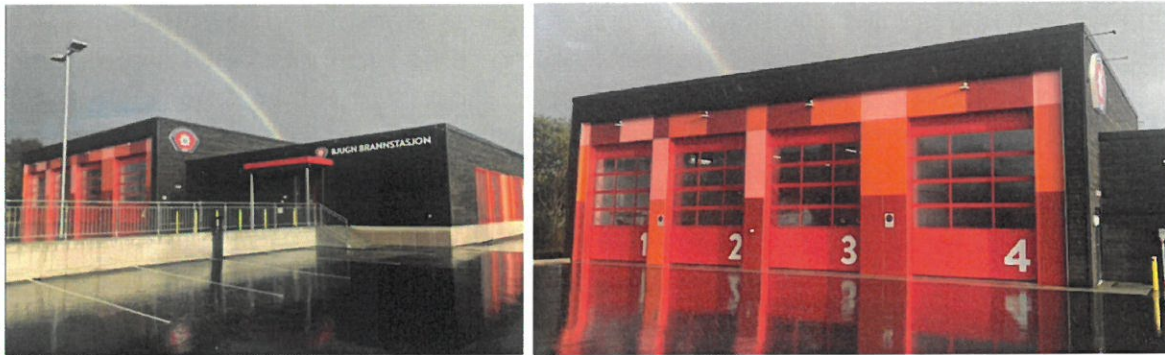
Bilde 9: Bjugn brannstasjon. Foto: FBRT
